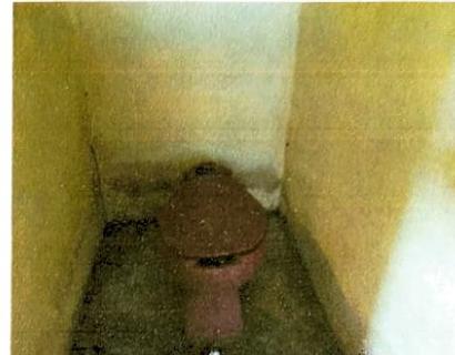
Foto 2: Sustitución de inodoro, piso cerámico y azulejo.
